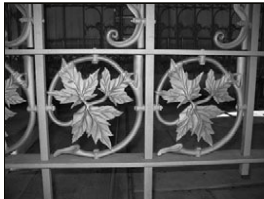
Triade de feuilles d'érable finement détaillées après un décapage aux microbilles de verre. Photo : Jean-François Cossette
