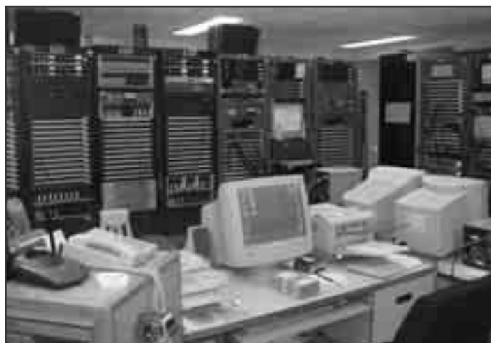
Régie centrale audio située au 2 e sous-sol de l'Hôtel du Parlement. Elle gère tous les signaux sonores venant des diverses salles de l'Assemblée nationale. C'est également à partir de cette régie que ces signaux sont émis aux diverses clientèles comme aux médias. Photo : Pierre Vallière, Assemblée nationale
