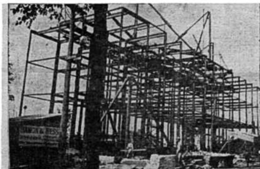
Photographie montrant la structure d'acier de la Bibliothèque du Parlement. — (Cliché par "Le Soleil")
