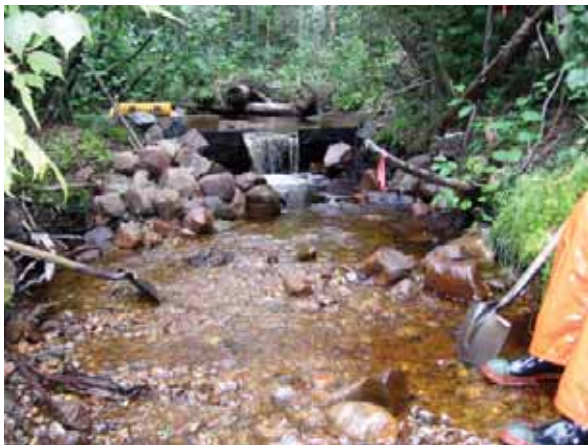
Aménagement d'un seuil sur le tributaire T5 afin de diminuer la hauteur de chute
