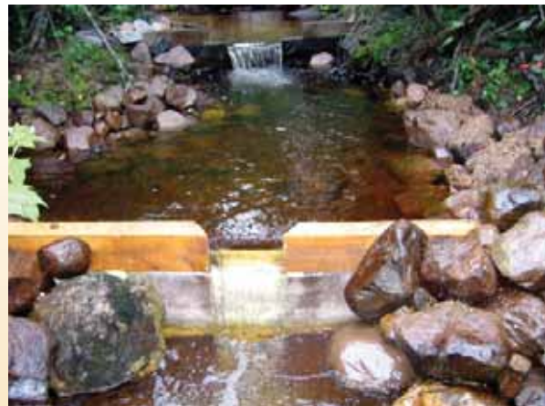
Aménagement d'un seuil sur le tributaire T5 afin de diminuer la hauteur de chute
