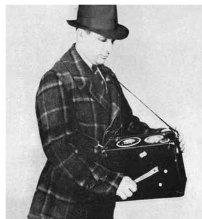
Une autre photo tirée du Manuel de sauvetage et de premiers soins dans les mines de 1951 qui montre un indicateur à main d'oxyde de carbone.
