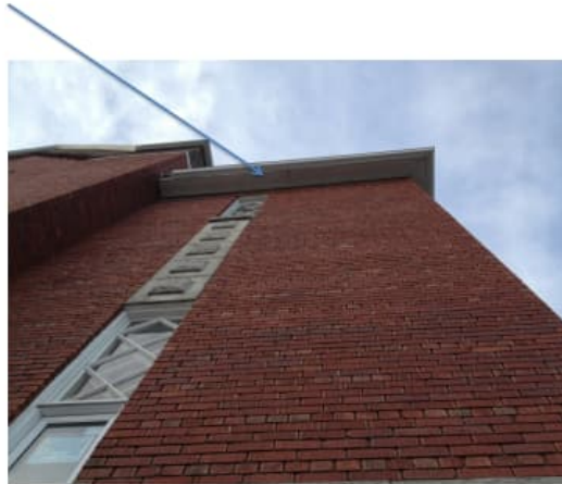
FIGURE H.4 — ÉLÉMENT DE STRUCTURE PERMETTANT DE CONTRÔLER L'ORIENTATION DU FLUX LUMINEUX
