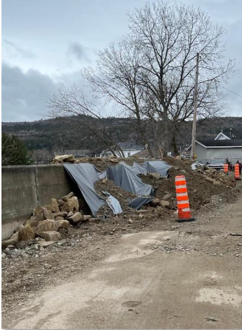
Figure 5. Réparations d'urgence effectuées sur la section endommagée du mur de la rue Ménard (à gauche) et sur le cadre bâti du secteur Ménard–Saint-Joseph (à droite)
