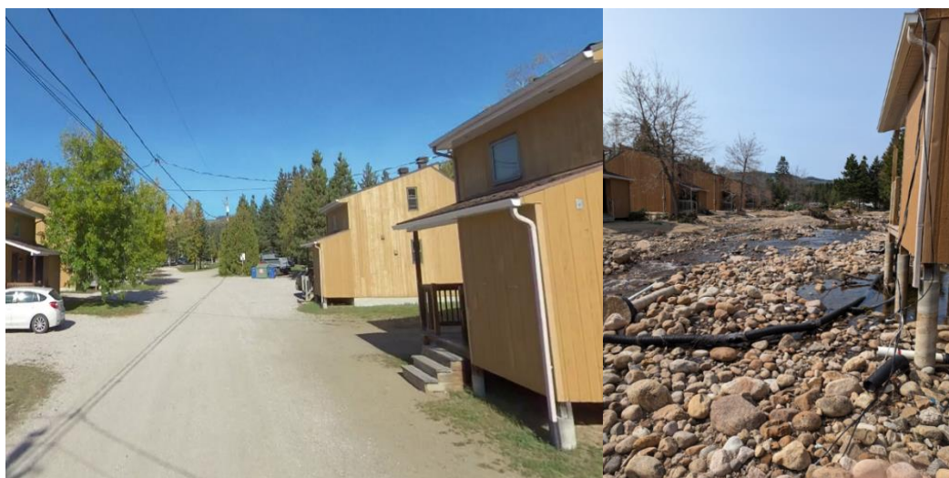
Figure 57. Avulsion du chenal de la rivière des Mares, camping Le Genévrier. Érosion verticale d'environ 60 cm près du pilier, en bas à droite
