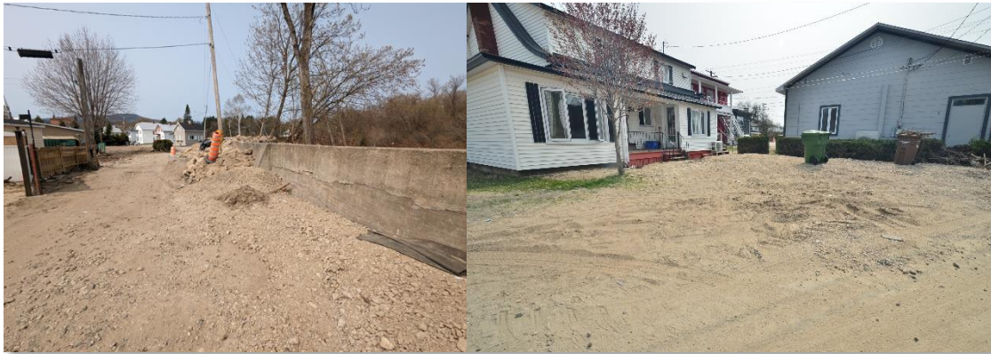
Figure 42. Rupture d'ouvrage et accumulation de sédiments fins, rue Ménard
