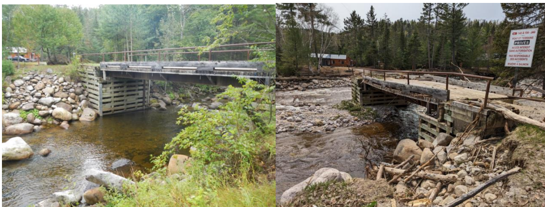
Figure 63. Pont privé de la rue du Bras à Saint-Urbain. Photo oblique du pont avant l'événement, le 24 août 2022, et après l'événement, le 8 mai 2023. Élargissement marqué de la largeur du chenal (au niveau du pont) d'environ 15 mètres avant l'événement et d'environ 45 mètres après
