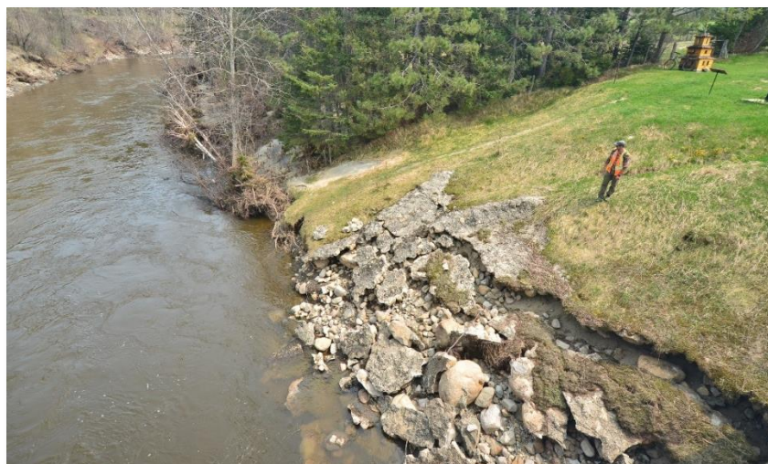
Figure 70. Érosion de l'ancrage du pont à l'intersection de la rue Sainte-Anne et du rang Saint-Jean-Baptiste, à Saint-Urbain
