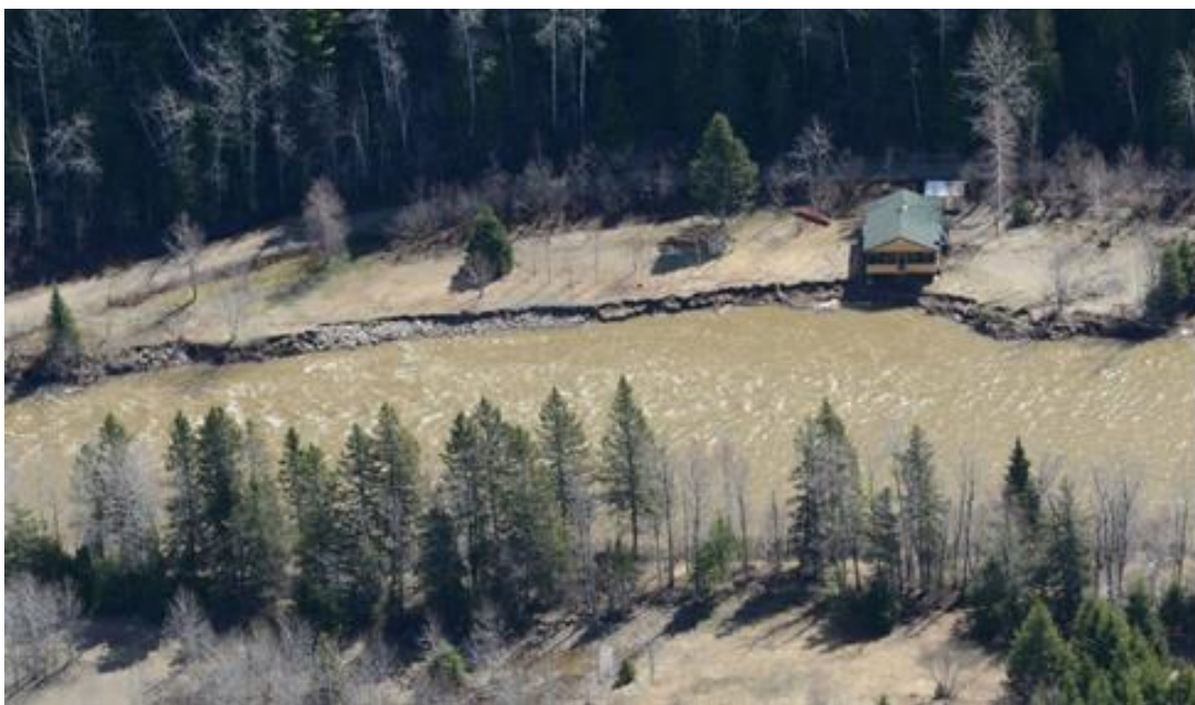
Figure 24. Exemple d'érosion sévère dans un talus de moins de 4 mètres de hauteur, devant un chalet en rive gauche le long de la rivière du Gouffre en aval de Saint-Urbain (photo MTMD – 2023-05-05)
