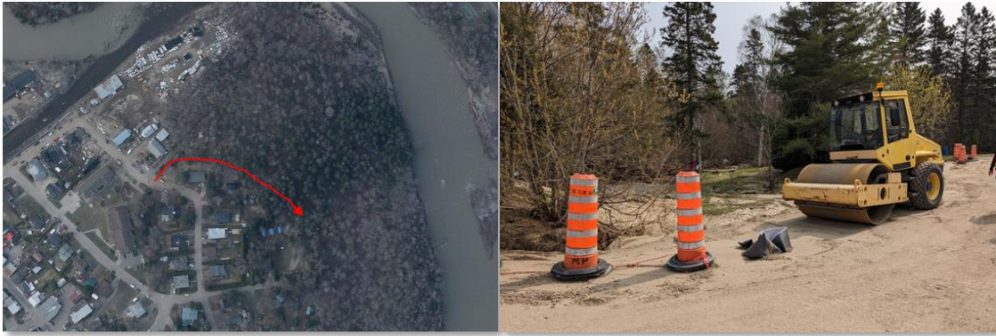
Figure 46. Secteur de la confluence des rivières du Gouffre et du Bras du Nord-Ouest. Ouvrage de la rue Saint-Pierre. Canal de débordement (flèche rouge) emprunté par le Bras du Nord-Ouest. La rue Clarence-Gagnon a été partiellement érodée. Présence d'un fossé de drainage à quelques mètres à gauche
