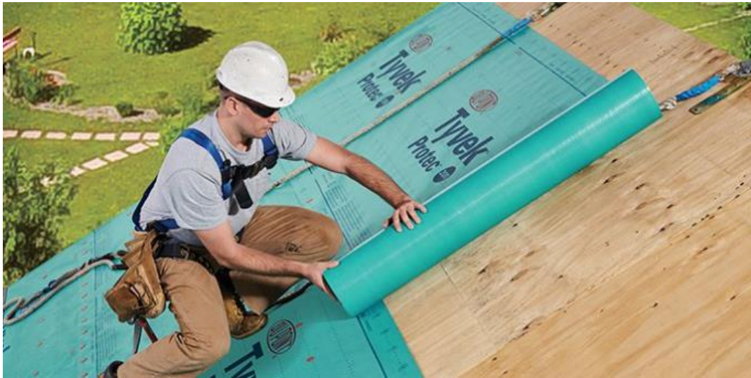
Figure 10: Installation d'une sous-couche synthétique
