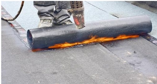
Figure 2: Structure et installation d'une toiture bicouche en élastomère
