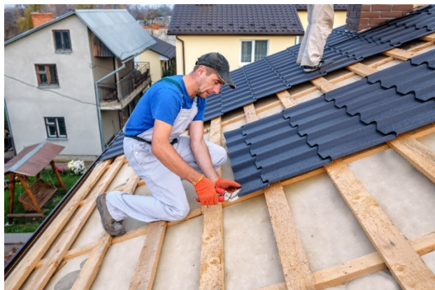
Figure 6: Structure et installation de profilés en acier
