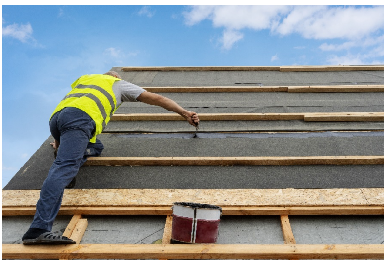
Figure 9: Installation d'une sous-couche asphaltée
