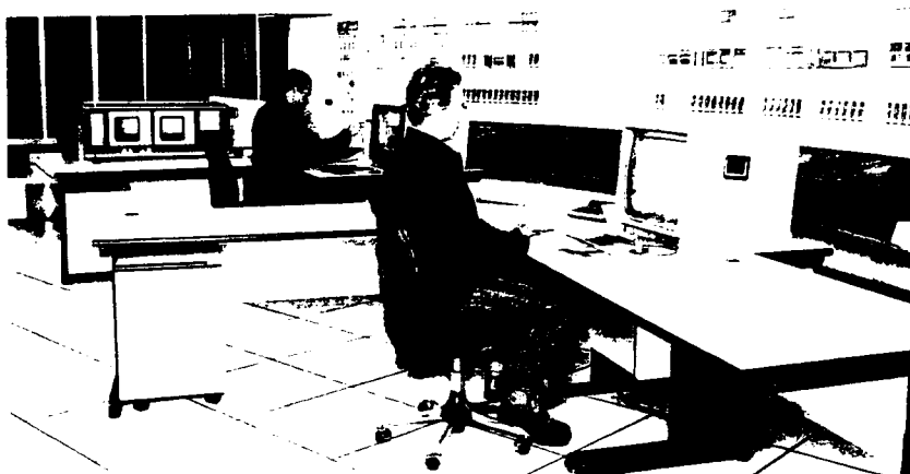
L'unité de production de chaleur de Metz équipée pour la cogénération chaleur-électricité réunit en un même lieu la collecte d'informations, la surveillance des deux réseaux (chaleur et électricité), la gestion et l'anticipation des demandes thermiques et électriques. Le système informatisé de télégestion est un véritable cerveau de décision technique et économique.
