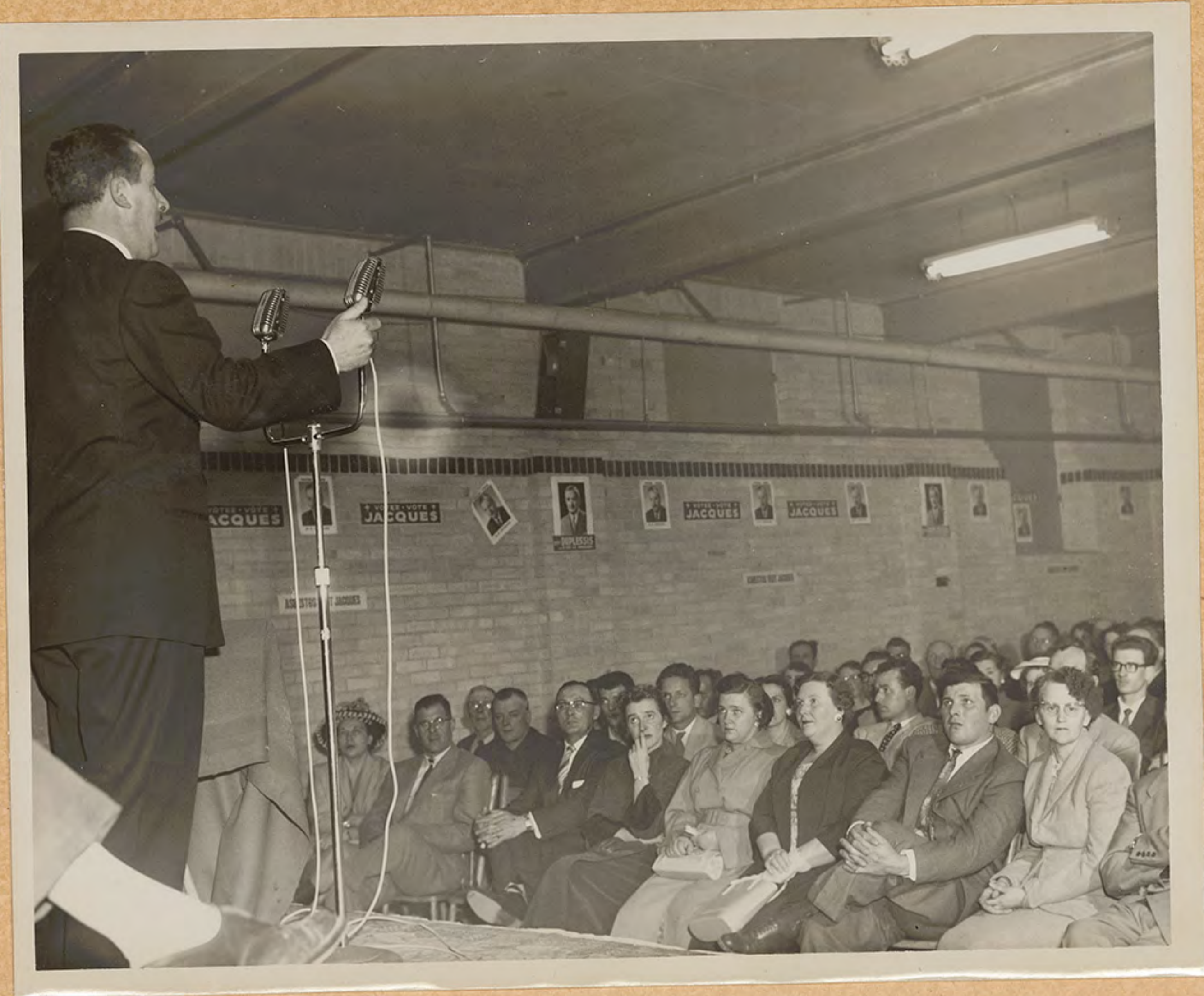
....." MAIS GARDEZ LA DONC CETTE LIBERTE". ASBESTOS.
